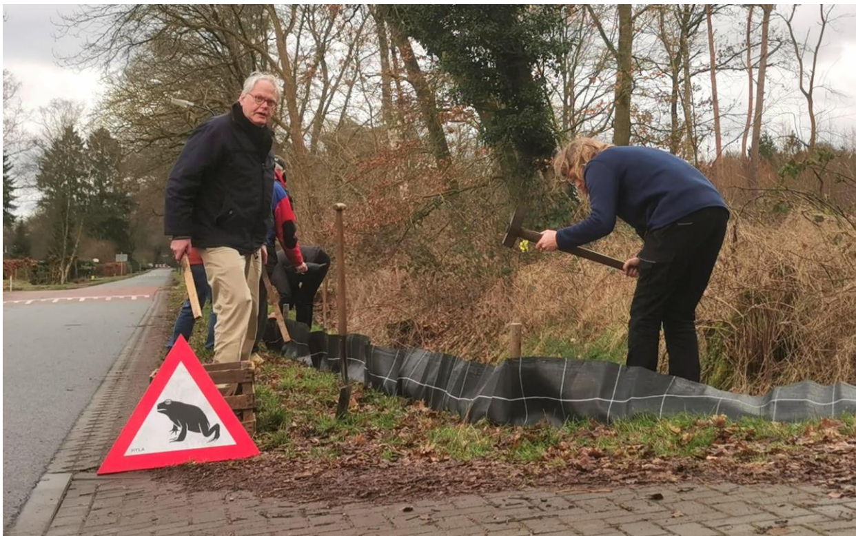
Tim de Wolf, coördinator van de paddenwerkgroep, bezig met andere vrijwilligers langs de Wieksloterweg met het aanleggen van paddenschermen. Foto Ton Paauw
