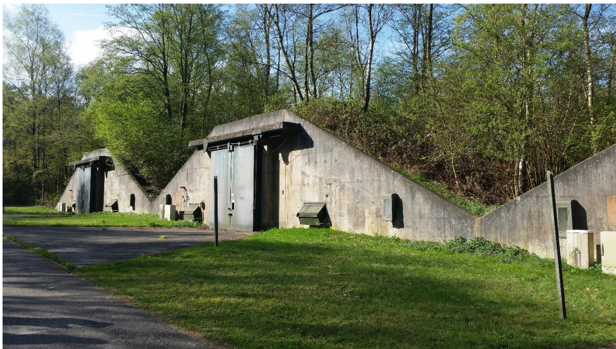
De zogeheten iglo's, munitiebunkers op de voormalige vliegbasis. Er verblijven vijf soorten vleermuizen.
