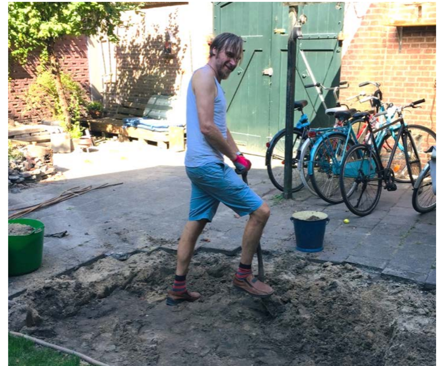
Tegels eruit, spade erin! Graafwerkzaamheden prototype Utrecht.
