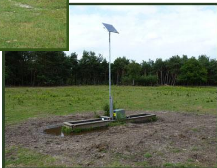
Pomp op zonne-energie
