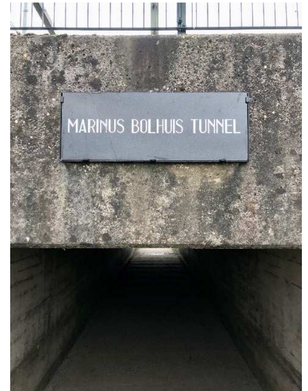
De Marinus Bolhuistunnel, de ingang aan de westkant van De Vork.
