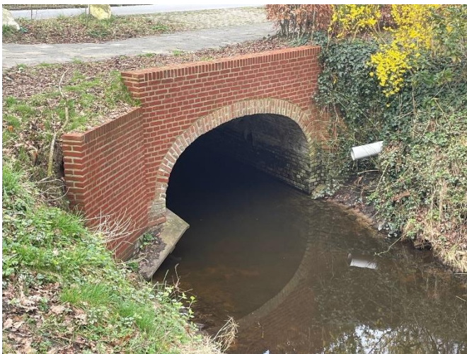
★ Otterplanken onder het bruggetje in de Veenweg over de Woldsloot
